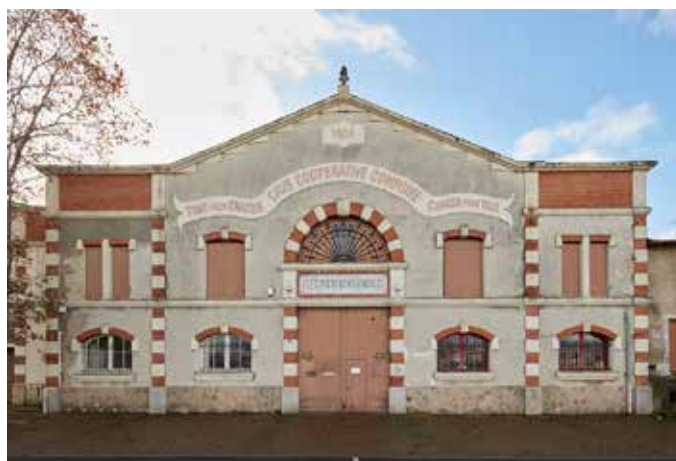
Cave coopérative de Maraussan (Hérault), première cave coopérative de France, détail de la façade, 1905
